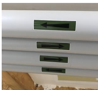
Exemple étiquettes de repérage des réseaux
