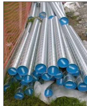
Stockage de gaines avec bouchons rigide
